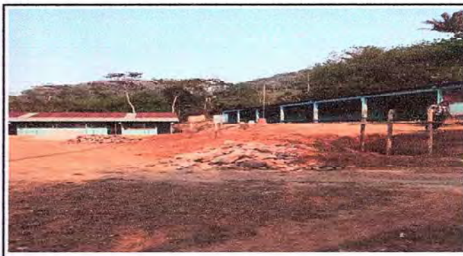
Foto 4: Sustrución de muro perimetral enfrente
