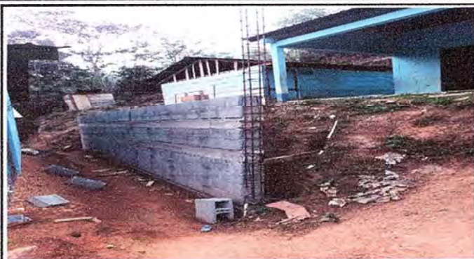
Foto1: Sustrución de muro perimetral
