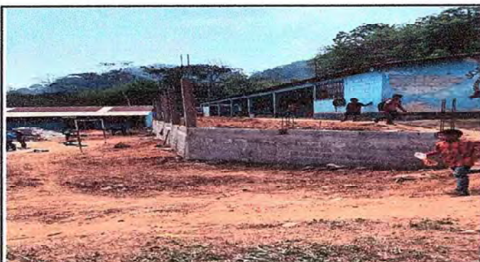
Foto 3: Sustrución de muro perimetral lateral derecho
