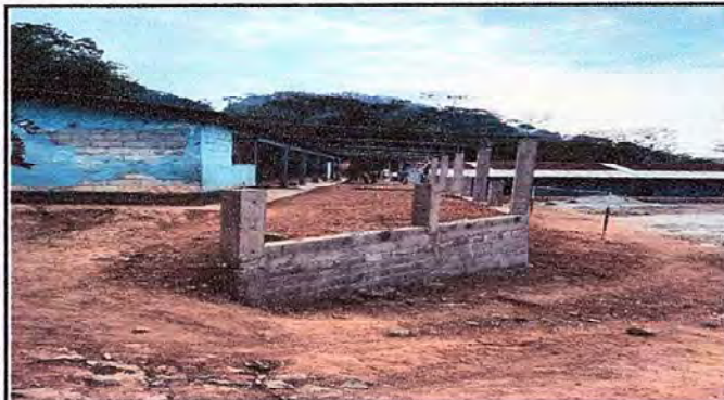
Foto 2: Sustrución de muro perimetral lateral
