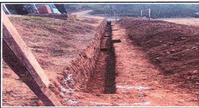
Foto 5: Cimiento para sustrución de muro perimetral
