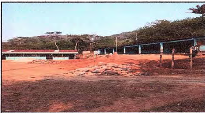
Foto 6: sanjeo para sustrución de muro perimetral
